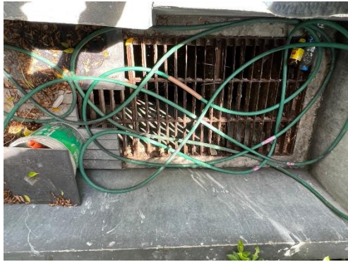
บ่อพักสุดท้ายพร้อมตะแกรงดักขยะ
