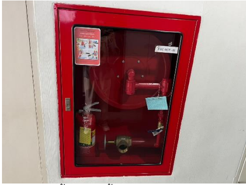
ตู้เก็บน้ำสายฉีดน้ำดับเพลิงและอุปกรณ์
