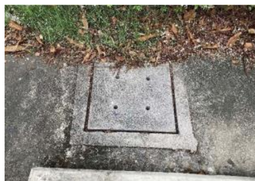
บ่อพักน้ำและท่อระบายน้ำนอกอาคาร
