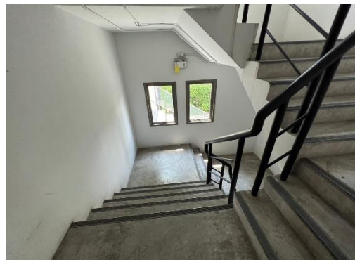
ช่องเปิดอากาศระบายอากาศบันไดหนีไฟ
